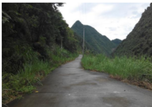
进场道路两侧植被恢复情况
